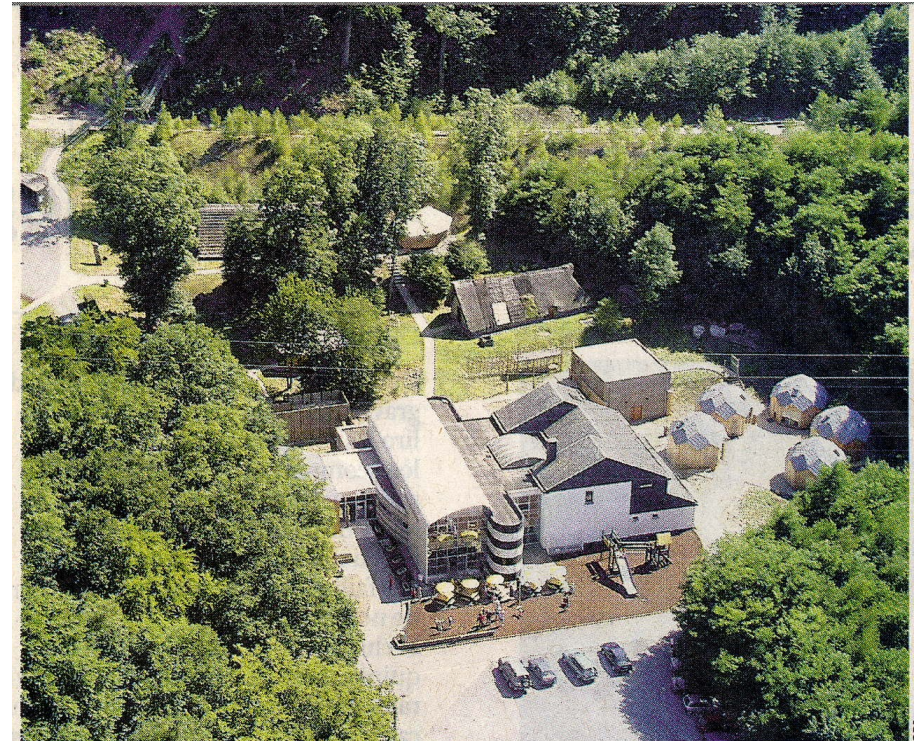
Les nouvelles infrastructures devraient être inaugurées en avril 2013.
